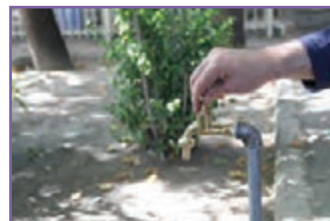
خ - آزمایش آب بندی شیر
