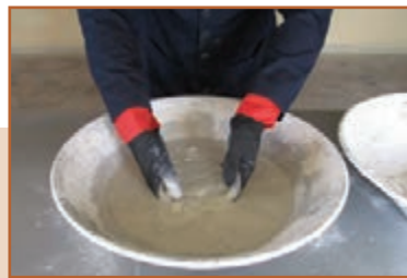
ت - مخلوط کردن گچ و آب با هم زدن آنها
