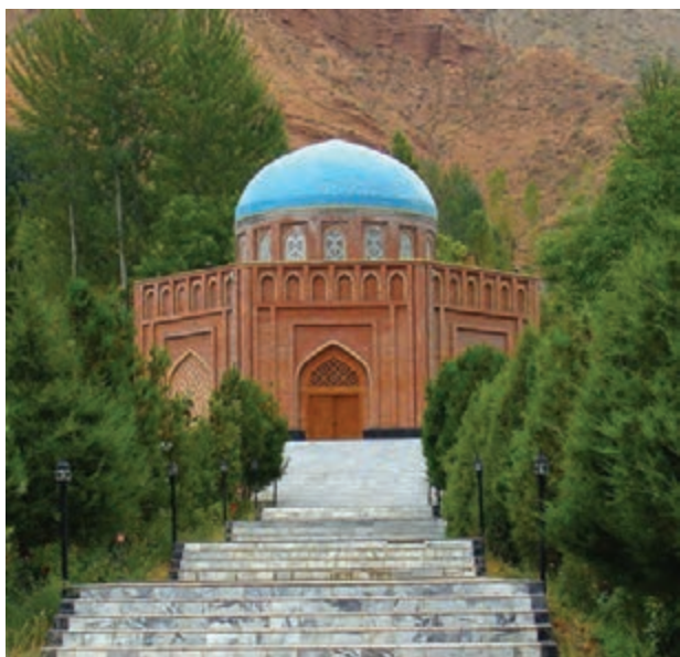
○ آرامگاه رودکی پس از بازسازی — پنجکنت، تاجیکستان
