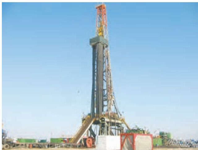
شکل ۱۰- دکل حفاری چاه‌های اکتشافی نفت و گاز
