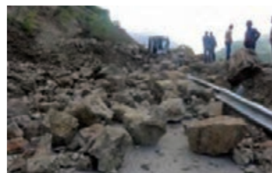
شکل ۱۳-۶ ریزش مصالح
