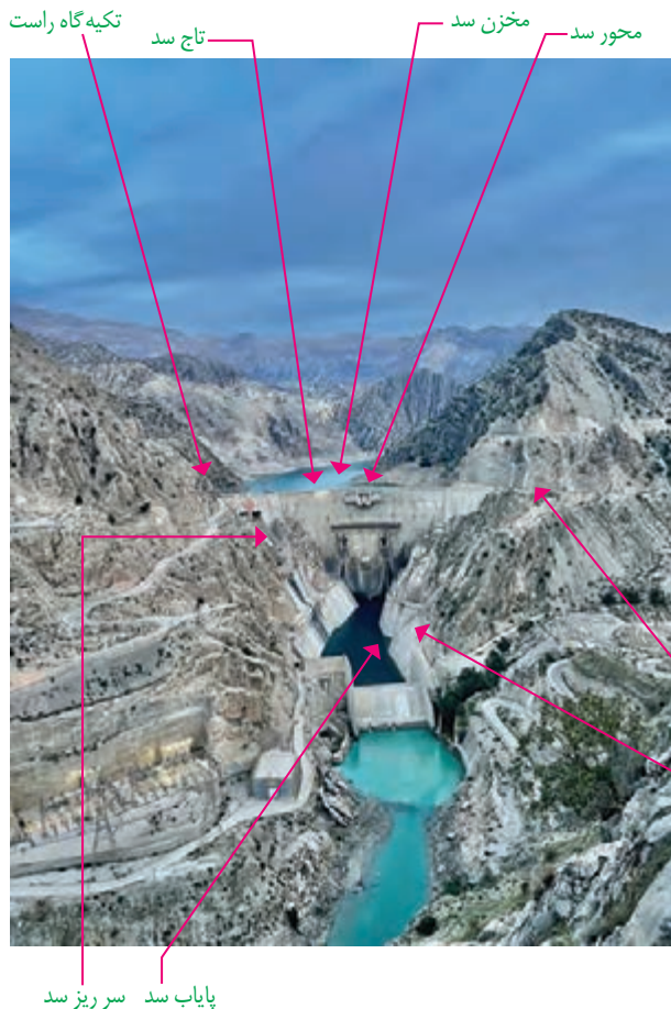
شکل ۱۷-۶-۱ نمای از بخش‌های مختلف یک سد
