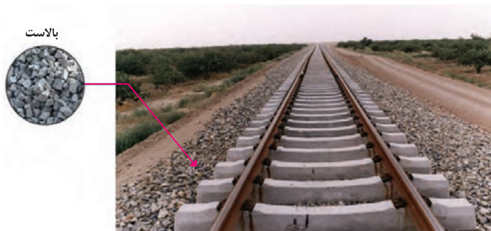
شکل ۶-۲۲. بالاست استفاده شده در زیرسازی جاده ریلی
