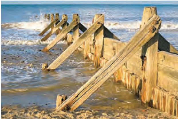
نصب حفاظ عمودی
