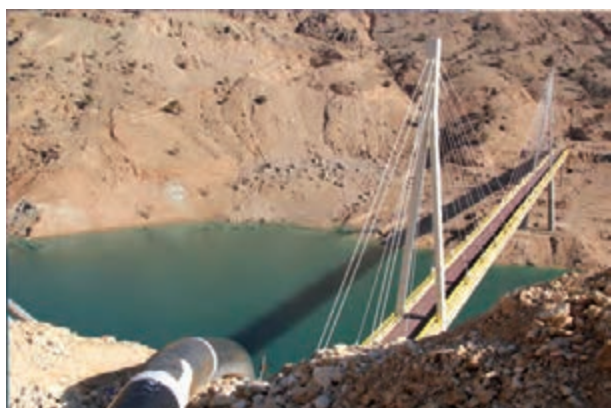
خط لوله مارون ایران که از مناطق صعب العبور و از روی پل و رودخانه عبور کرده است.
