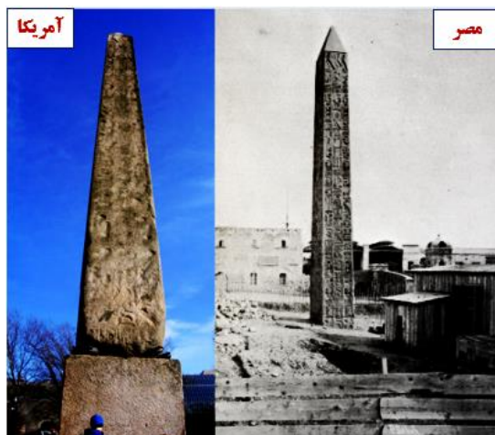
شکل ۱۱: نقش هوازدگی در تخریب سوزن کلئوپاترا
