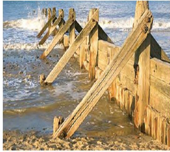
نصب حفاظ عمودی
