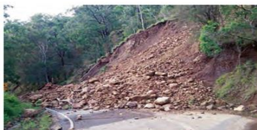
زیربُری دامنه برای ساخت جاده و وقوع لغزش
